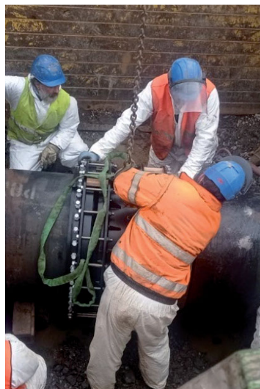
Foto z průběhu montážních prací
